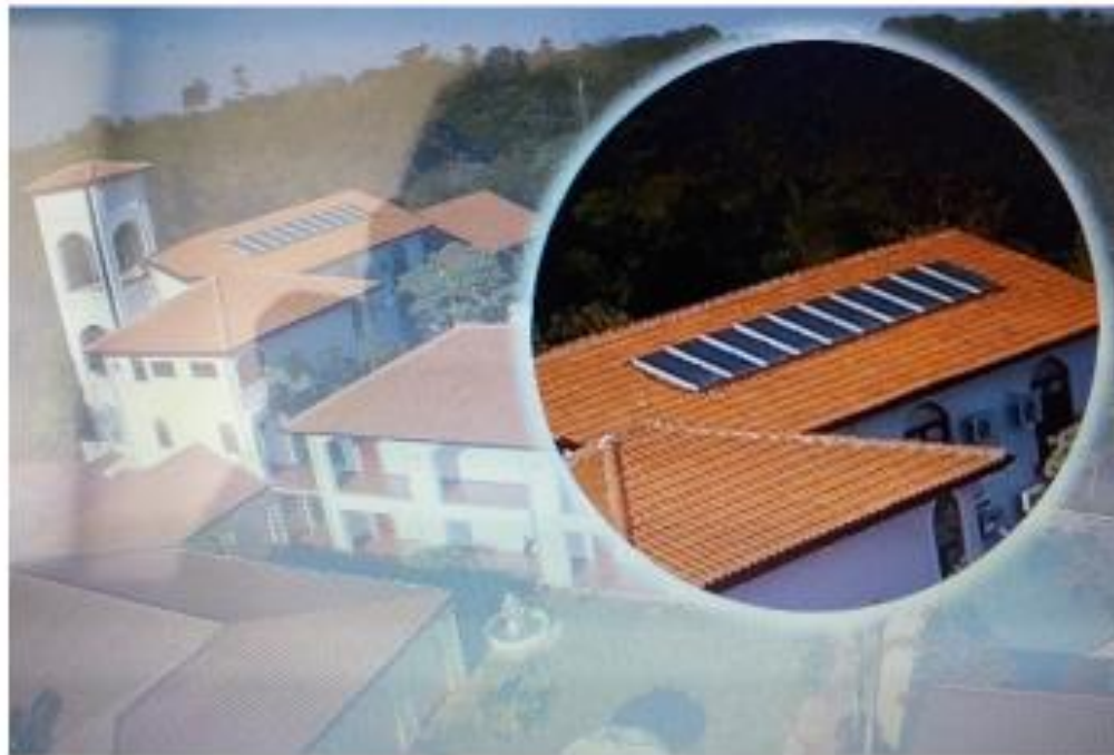
Utilización de paneles solares para el calentamiento de agua del Hotel
