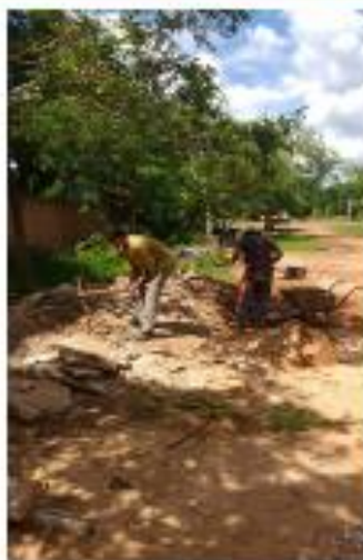
Reuso de escombros para la realización de reparaciones
